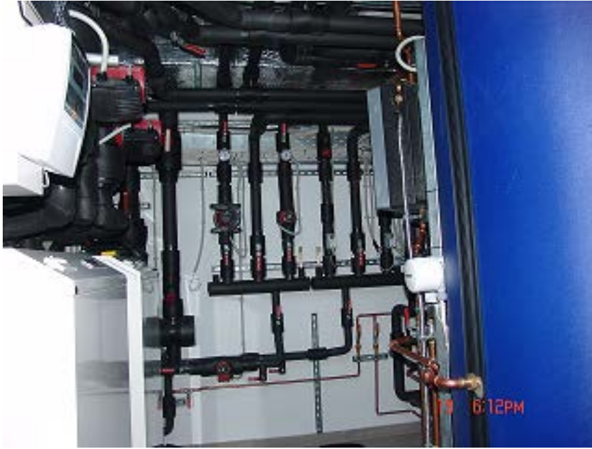
ΕΙΚΟΝΑ 41: Φωτογραφία μηχανοστασίου
